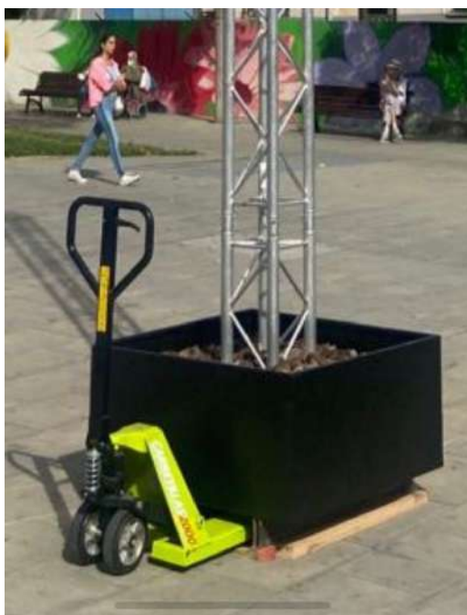
3. Trasllet de l'estructura amb transpaleta.
